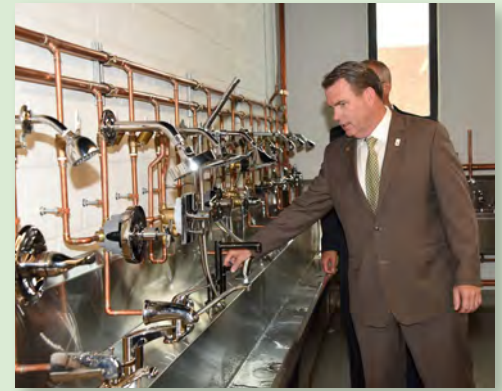
Faucet Wet Lab.
